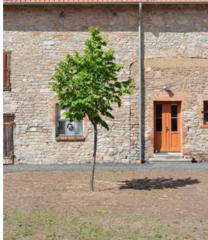
An allen Ecken des Schlosses wird gebaut. So wird neben den Ferienwohnungen, ein Teil des Areals als Pferdestall und Koppel genutzt. Dienstags findet ein Seniorentreff in Räumlichkeiten des Schlosses statt. „Ich freue mich, wenn Menschen sich hier einbringen.“
